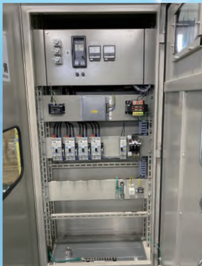
昇圧変圧器盤 内部(前面)
