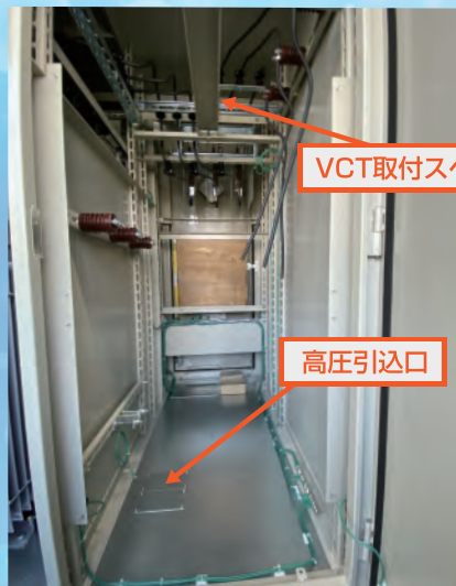
系統連系盤 内部(裏面)
